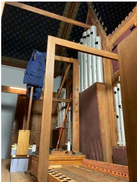
Die technische Montage ist als Einzelposten im Angebot aufgeführt. Oben sind Arbeiten im Zuge der Neuverlegung des Bleirohrs (s. Position e) zu sehen. Unten sieht man Reinigungs- und Montagearbeiten.
